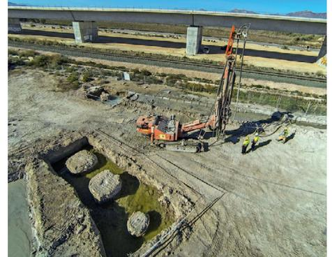
Pueden obtenerse significativas reducciones de vibraciones en suelos donde la barrera de jet grouting tiene mayor rigidez que el suelo blando original.
