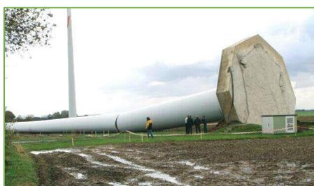
**Figura 7.** Vuelco de una torre de aerogeneradores
