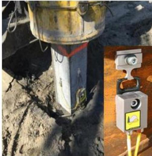
**Figura 7:** Equipo PDR. Transductores sobre la cabeza de un pilote y detalle de Sensor combinado extensómetro y acelerómetro.
