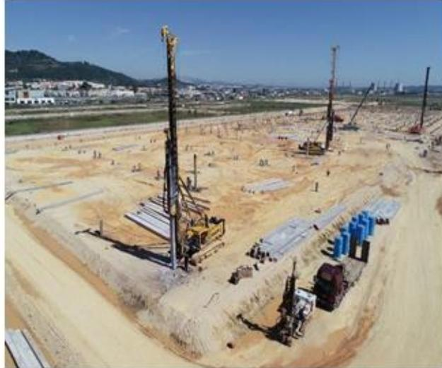
*Figura 6: Equipos utilizados en la ejecución de los pilotes prefabricados.*
